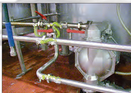
Bomba sanitaria de 3" usada para trasvasar bases cosméticas para shampoos.
