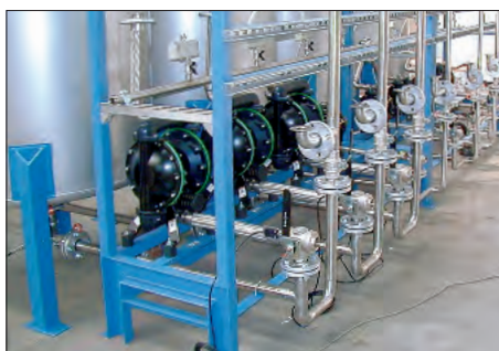
Bombas de membrana de 1 1/2" en aluminio, instaladas en la alimentación de un reactor química.
